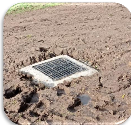
Changement des canalisations pour l'évacuation de l'eau sur la route d'Argenty
