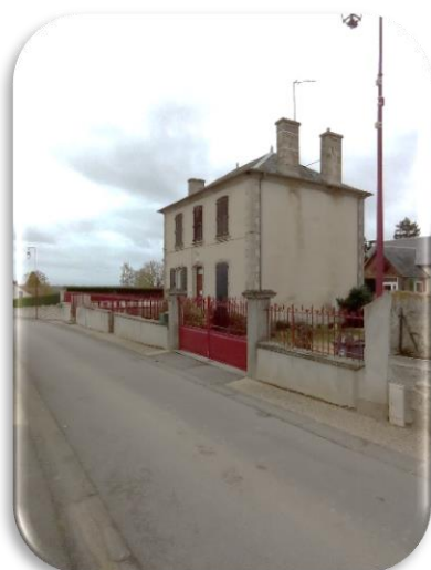
Installation de la fibre à la mairie et au CAC
