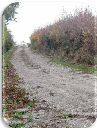
Remise en état du chemin et nettoyage des fossés par la société RAYMOND
