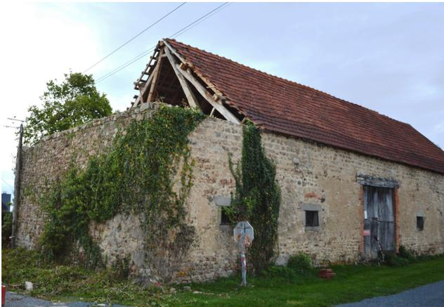
C'est chose faite depuis la fin de l'été grâce à la destruction de la 1ère ferme en toiture et l'abaissement du pignon au niveau des murs latéraux. Une ceinture en ciment a été faite par l'artisan en charge des travaux pour relier ces 3 murs qui n'étaient plus solidaires.
